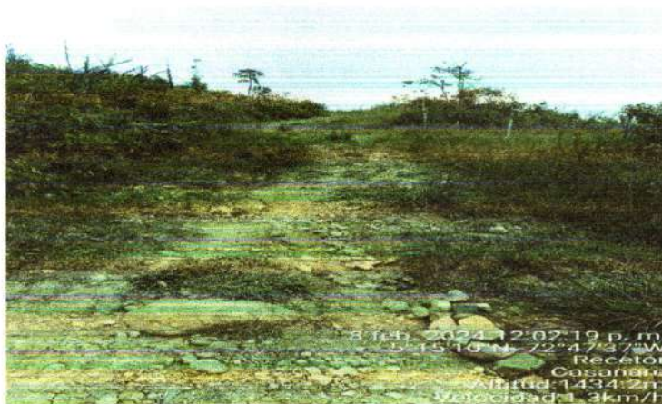
Ilustración 5 Condición Vías Terciarias de Recetor
