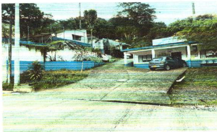
Ilustración 11 infraestructura centro de salud del casco urbano
