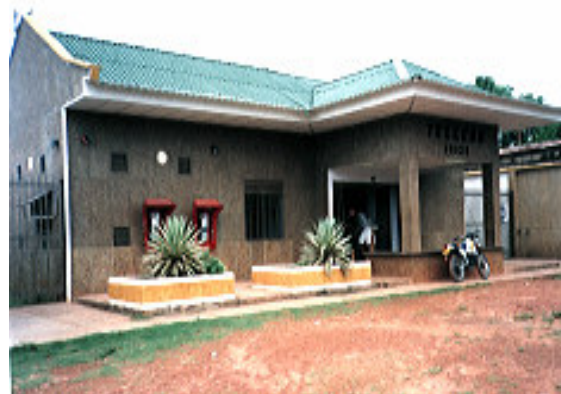
Foto 12. Instalaciones de Telecom.
