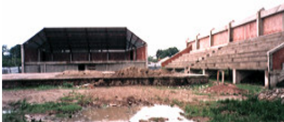
Foto 8. Polideportivo en construcción
