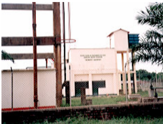
Foto 11 . Planta de tratamiento acueducto.
